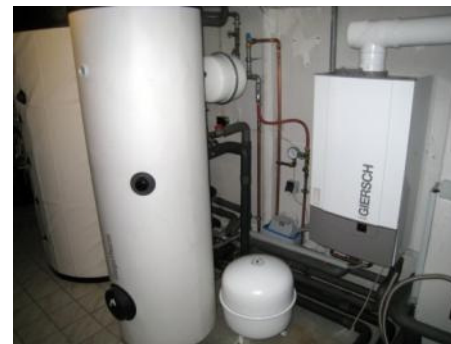
Austausch der Heizung
