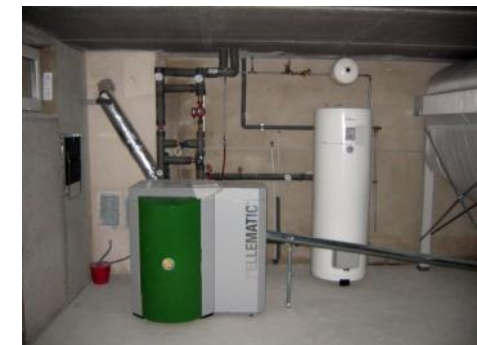
Austausch der Heizung
