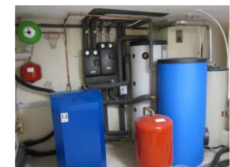
Austausch der Heizung
