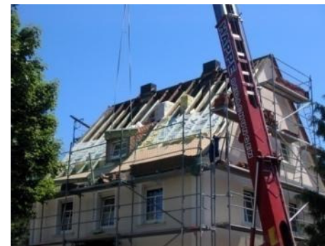
Aufdachdämmung (wg. Ausmauerung)
