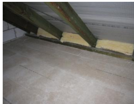
Dämmung oberste Geschossdecke
