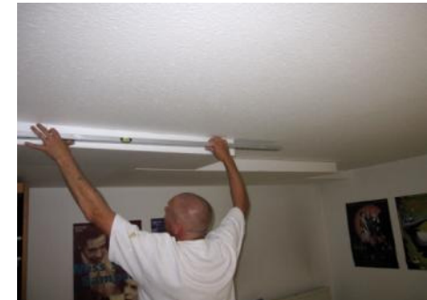
Dämmung der Kellerdecke
