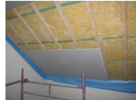
Dämmung der Dachschrägen
