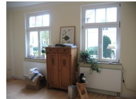
Austausch der Fenster, Haustür
