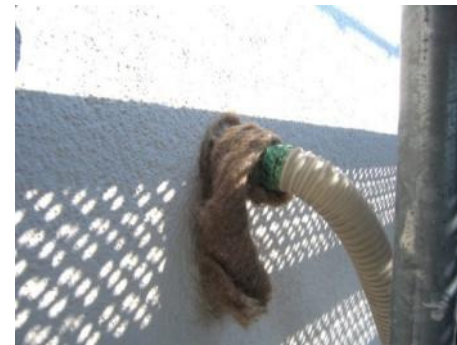
Kerndämmung der Außenwände
