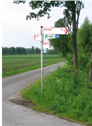
Nachher: Zielwegweiser mit Kilometrierung und Routeneinschüben
