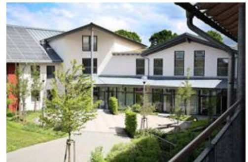
Technologiezentrum für Zukunfts-energien Lichtenau
