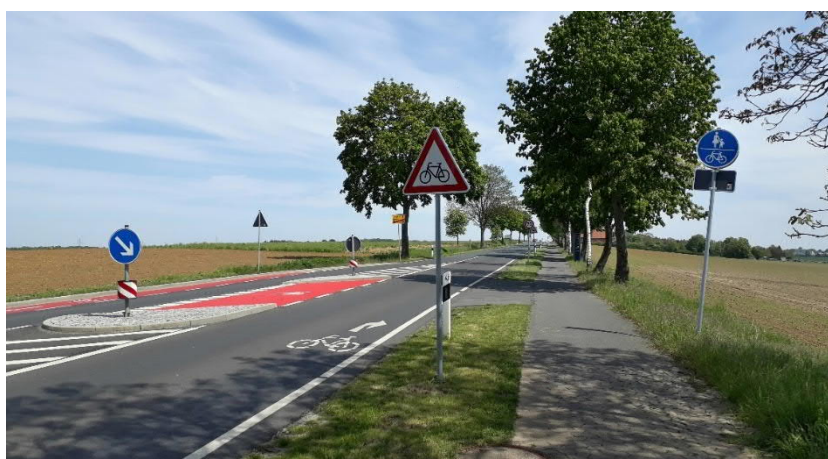
Abb. 15 Markierung von Fahrradpiktogrammen auf der Fahrbahn Übergang Fahrbahnführung innerorts und außerorts benutzungspflichtige Radverkehrsanlage (Seelze)
