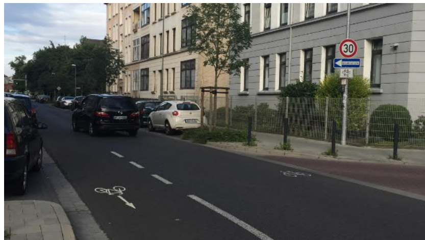
Abb. 13 Markierung von Fahrradpiktogrammen auf der Fahrbahn (Braunschweig)
